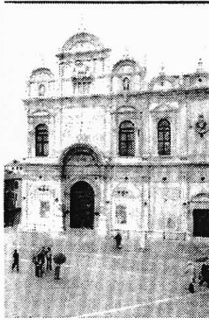
La facciata restaurata dell'Ospedale
